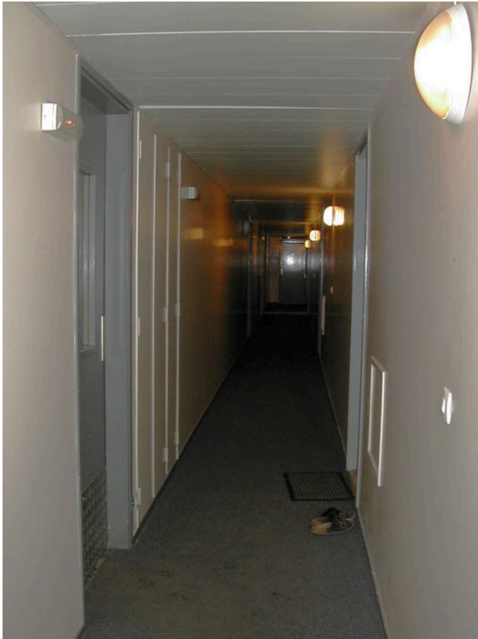
Couloir de distribution des appartements
