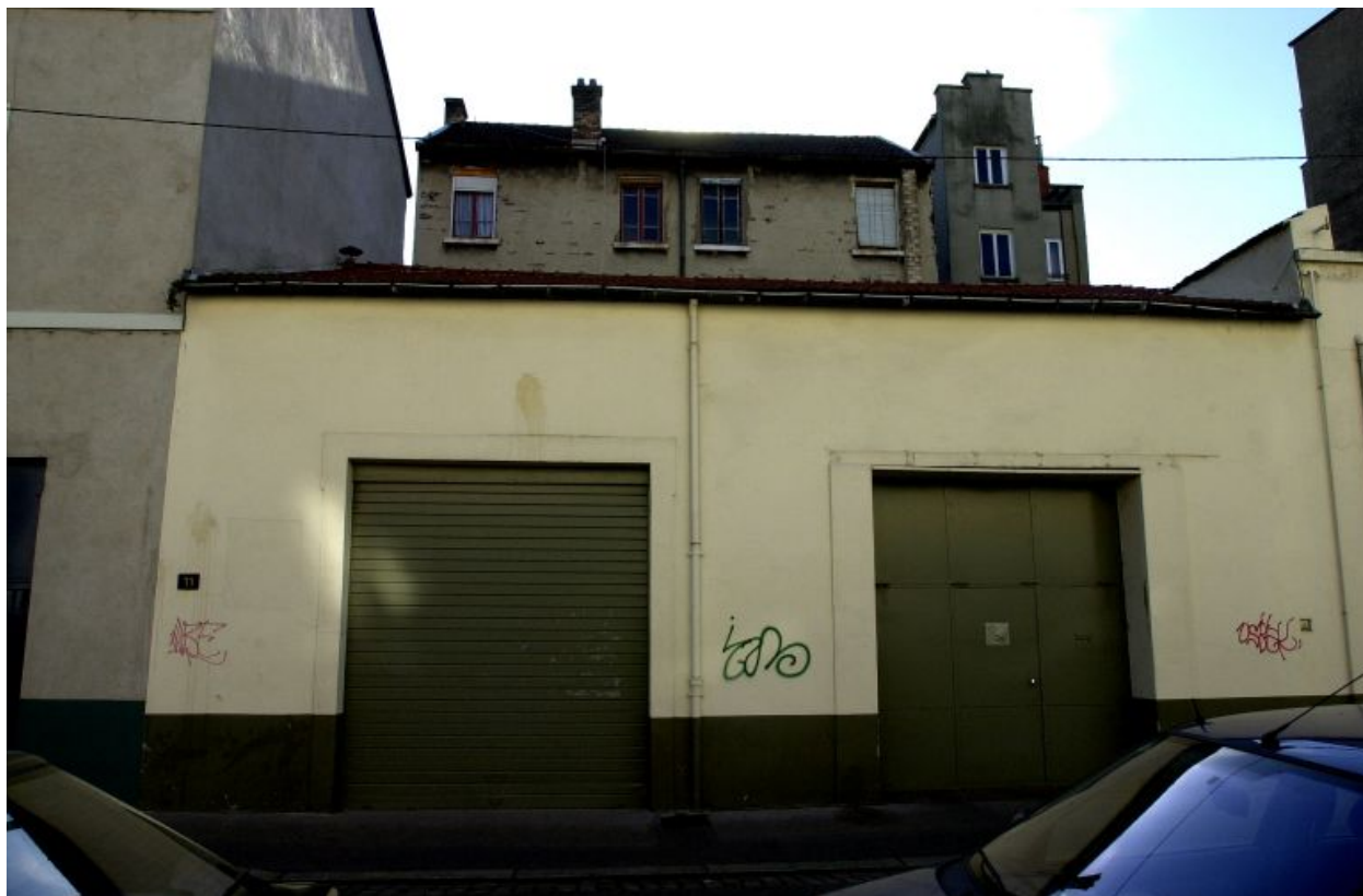
Elévation des garages, rue Seguin
