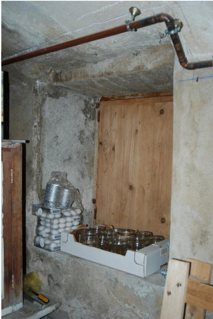
Rez-de-chaussée. Intérieur de la cave 2, ancienne baie murée située dans le mur sud.
