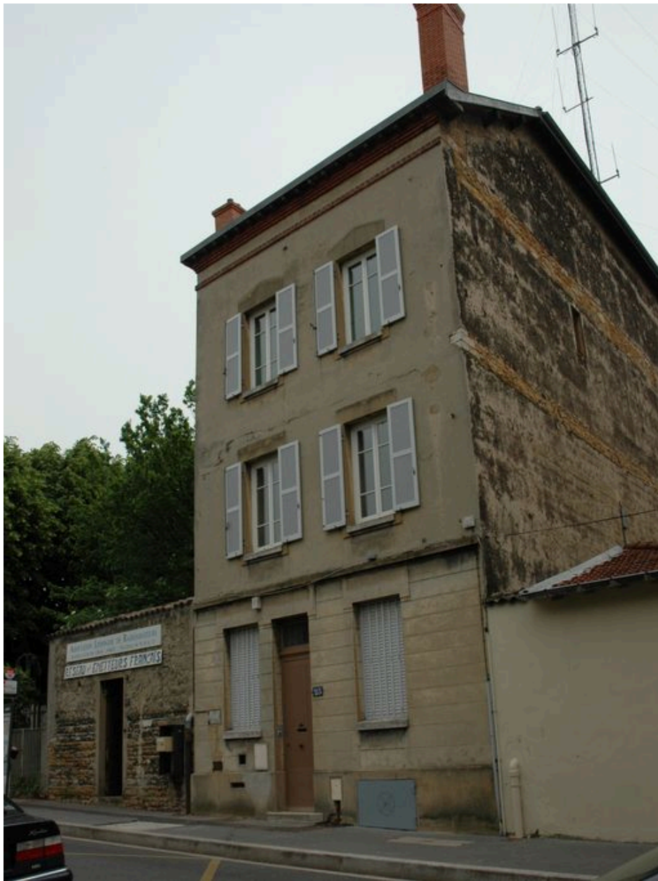
Bâtiment de la galerie, élévation sur la rue Roger-Radisson
