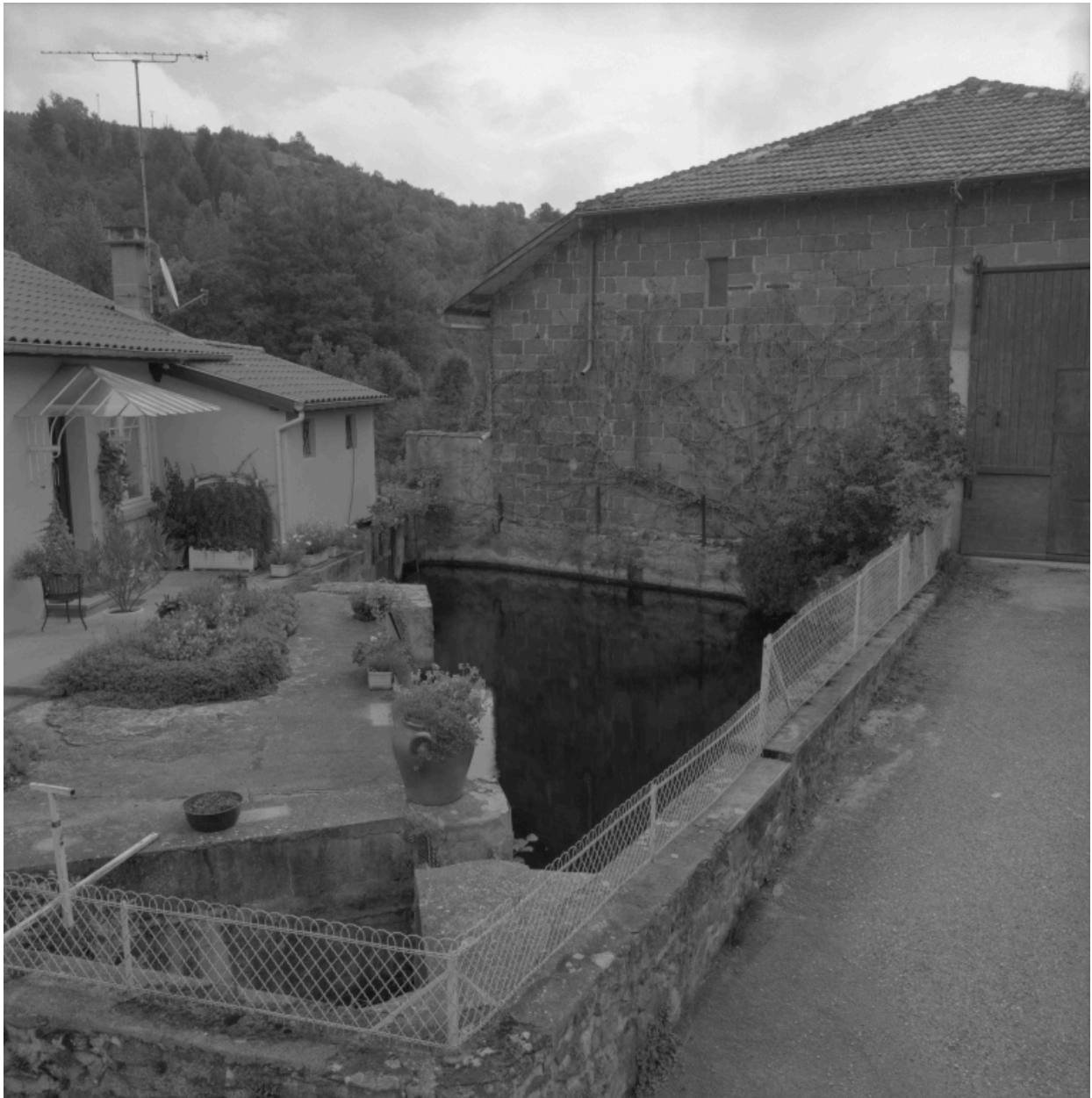
Vue d'ensemble du bâtiment de fabrication d'électricité avec au-devant le bief.
