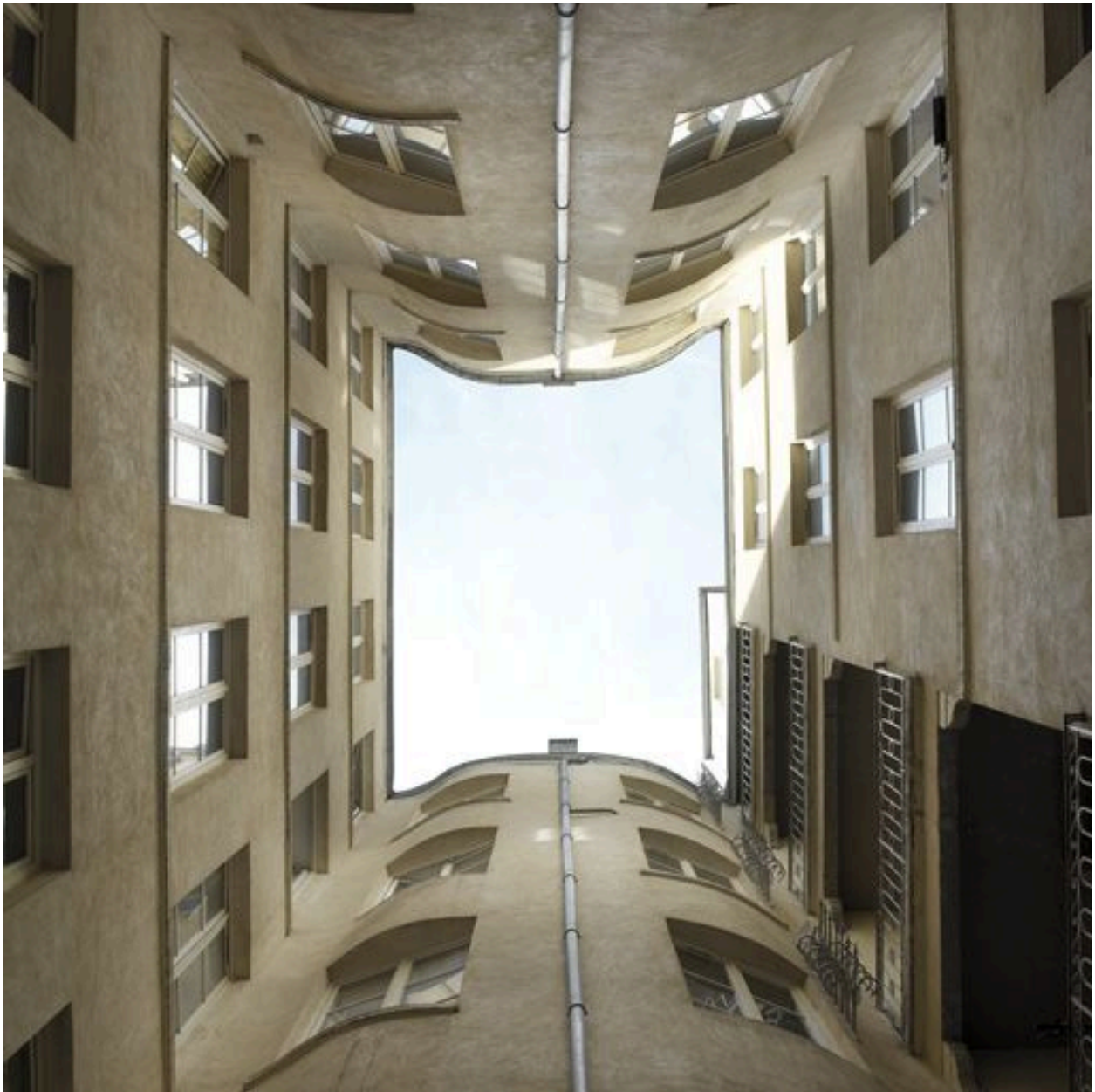
Première cour, vue générale par-dessous
