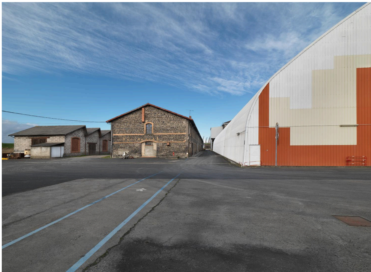
Vue des ateliers de stockage sud-est
