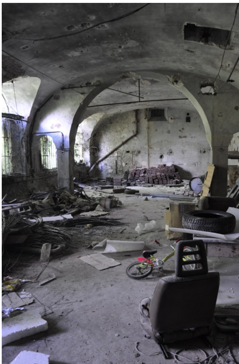
Vue intérieure du niveau de sous-sol
