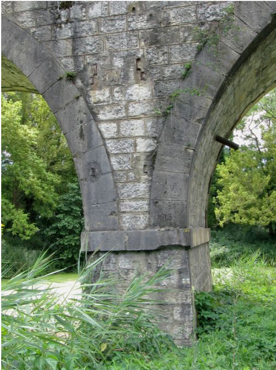
Vue d'une pile, face amont
