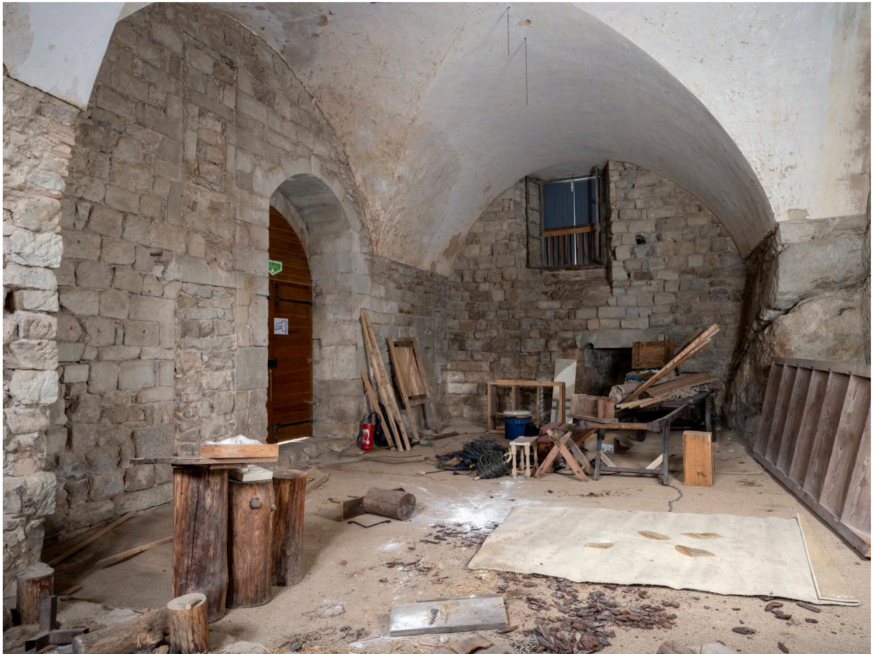
Châtelet, sous-sol : salle d'armes
