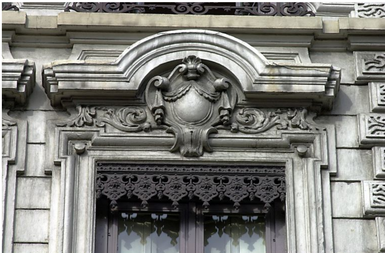
Façade principale, 4e niveau, détail d'une fenêtre des avant-corps latéraux
