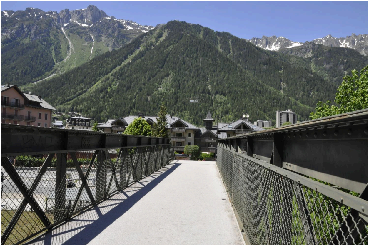
Tablier et garde-corps grillagé de la passerelle
