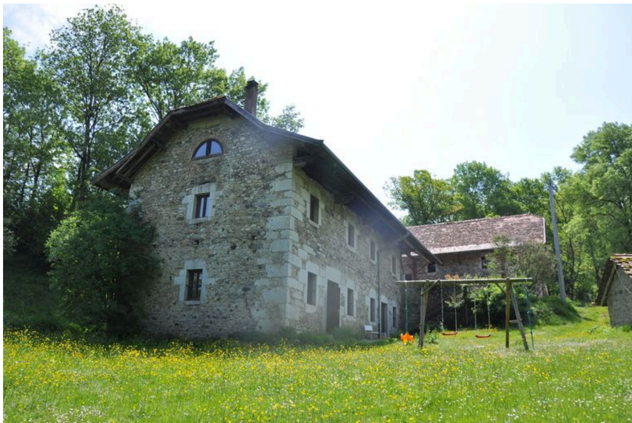
Elévation nord-ouest du moulin principal
