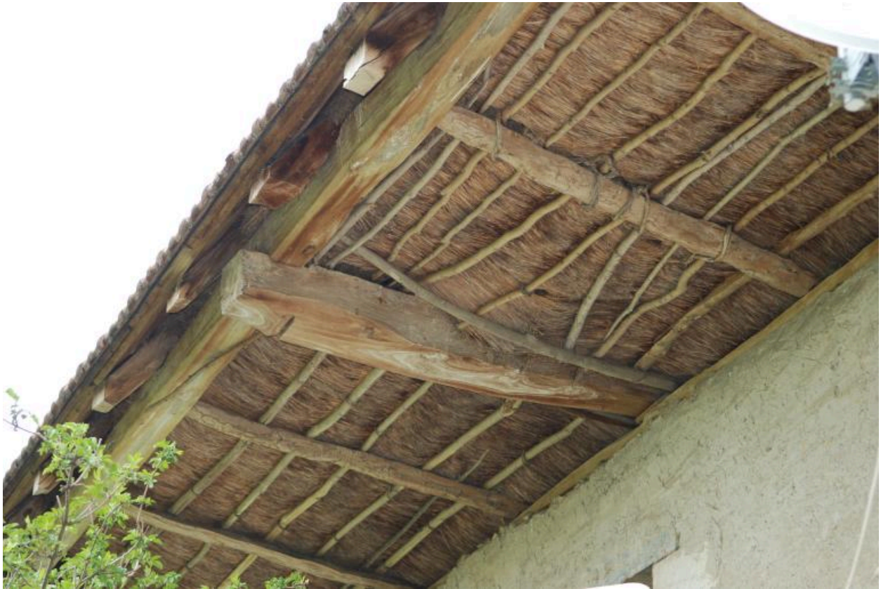
Détail de l'avant-toit couvert du mur pignon ouest de la ferme.
