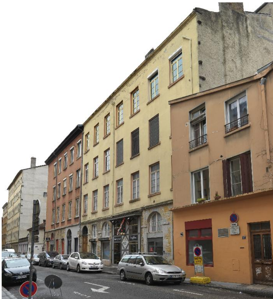
Vue d'ensemble du n°4 rue Dumenge depuis l'ouest
