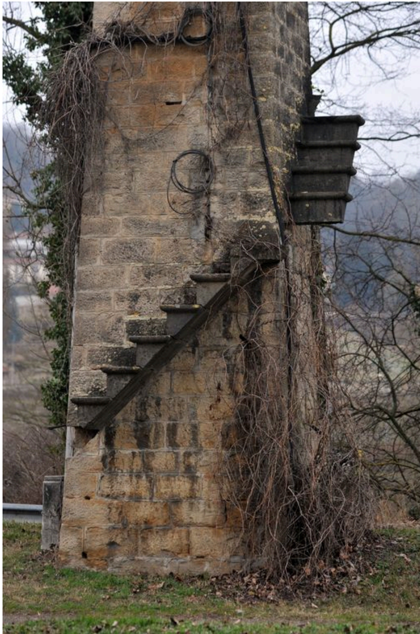
Pile gauche, angle est, vue partielle : escalier et ancrage du câble (depuis la rive gauche)
