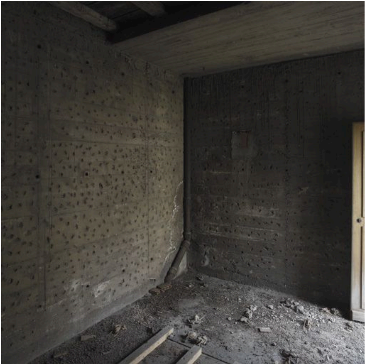
Intérieur du clocher. Détail des matériaux
