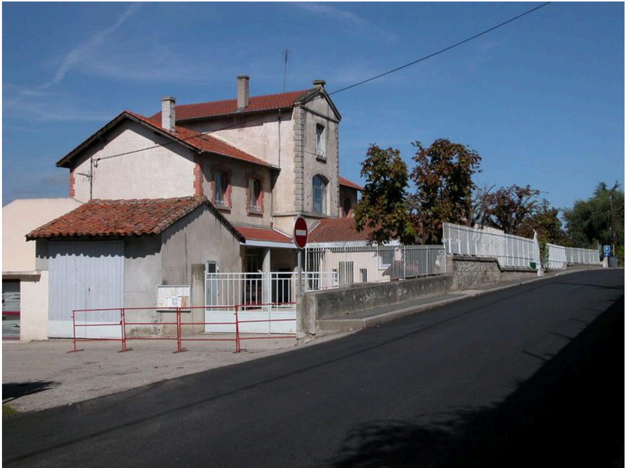
Vue d'ensemble de la mairie-école depuis l'est (Sous le Bourg, 1987 A 621, 623 et 627, recensée).
