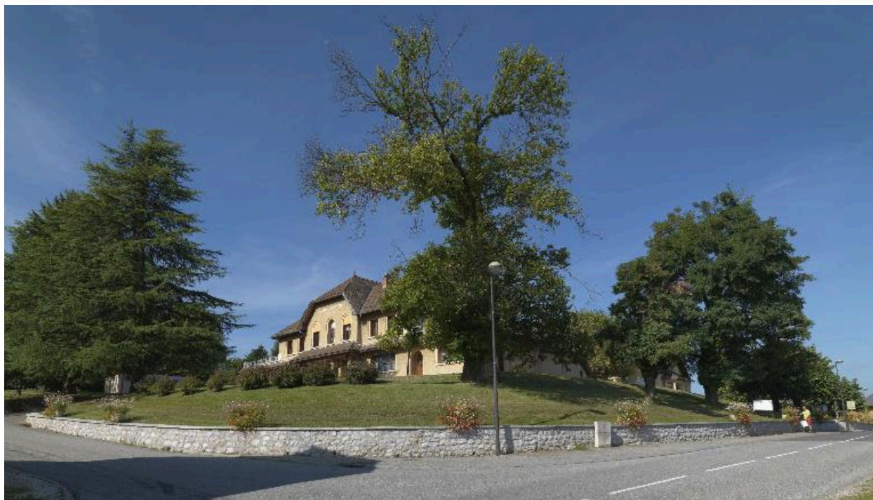
Vue d'ensemble de la mairie-écoles, depuis le nord-est.
