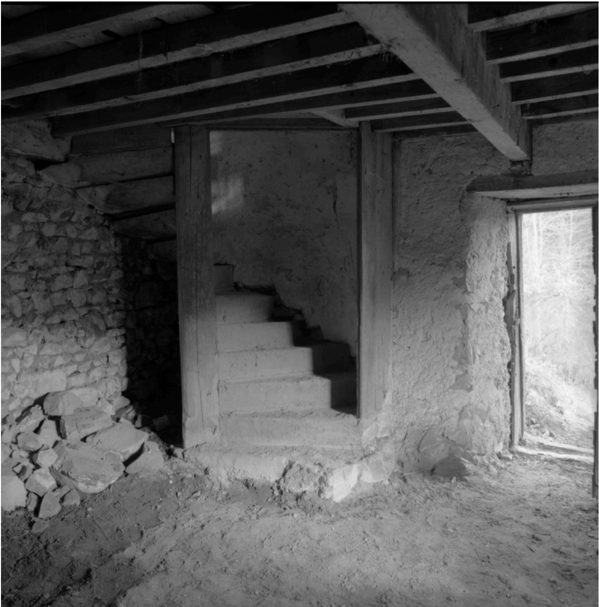
Vue intérieure du rez-de-chaussée : départ de l'escalier.
