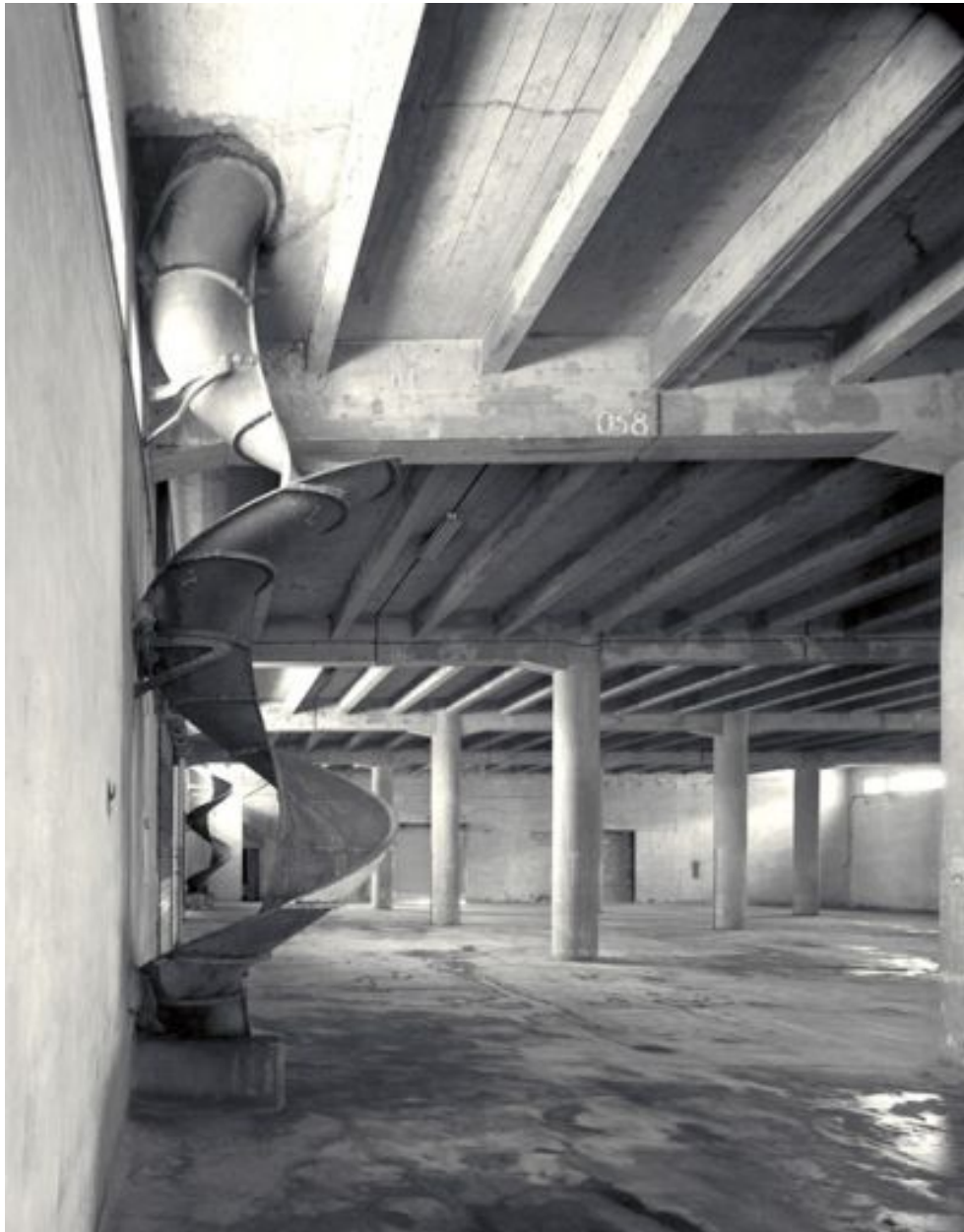
Intérieur du bâtiment de 1927 (bâtiment sud) : manutention du sucre en sac, les tourniquets verticaux
