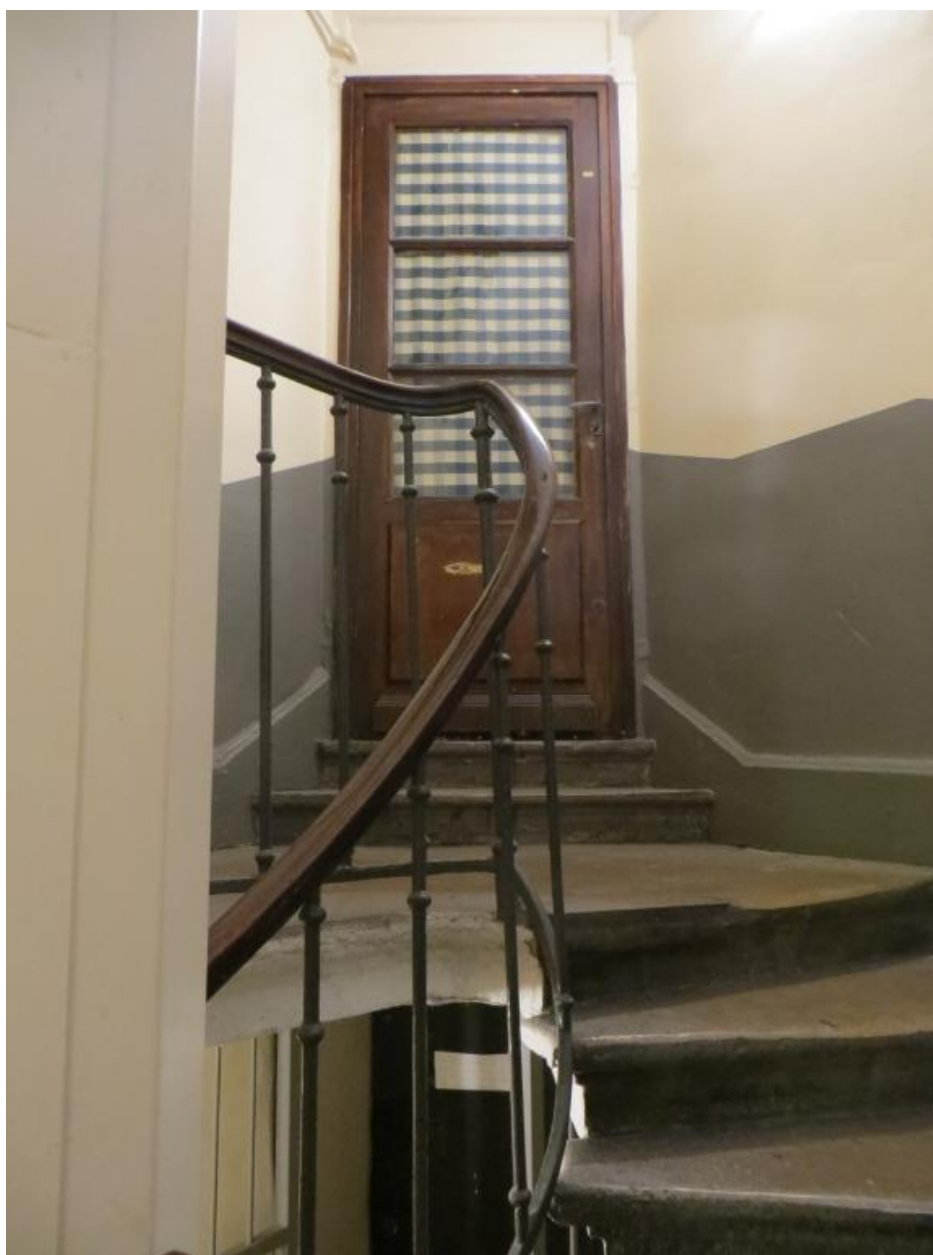
La porte de la loge de concierge depuis la première volée d'escalier
