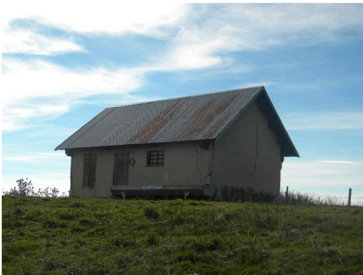
Vue d'ensemble du bâtiment.
