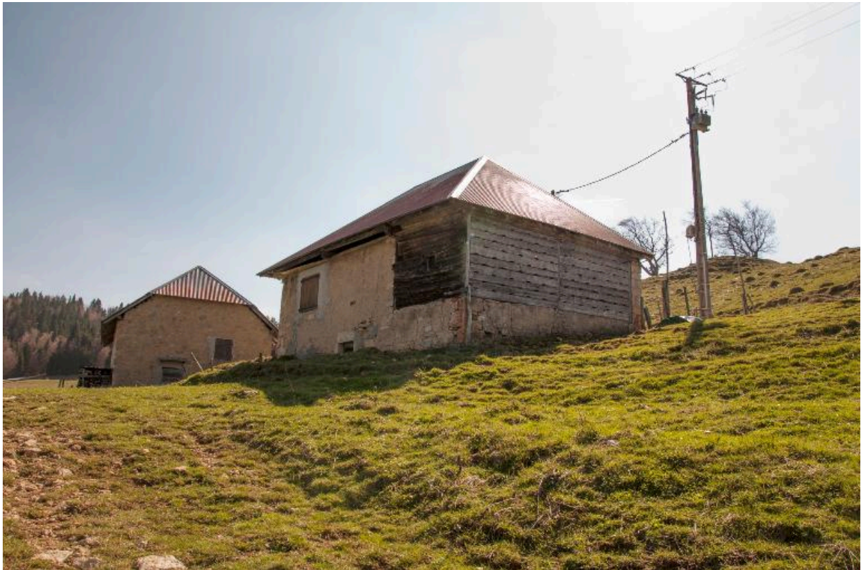
Vue des deux chalets d'habitation sur cave, depuis le nord-est.
