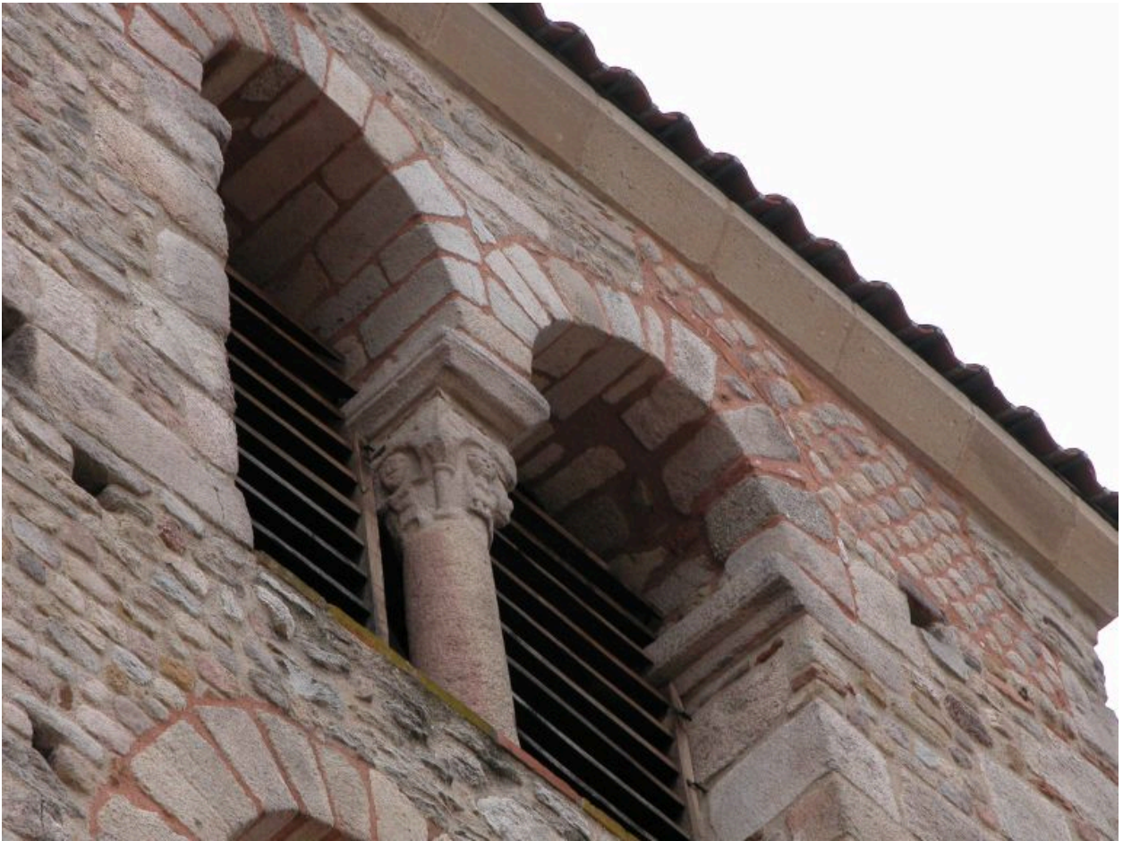
Détail baies jumelées du clocher, face est
