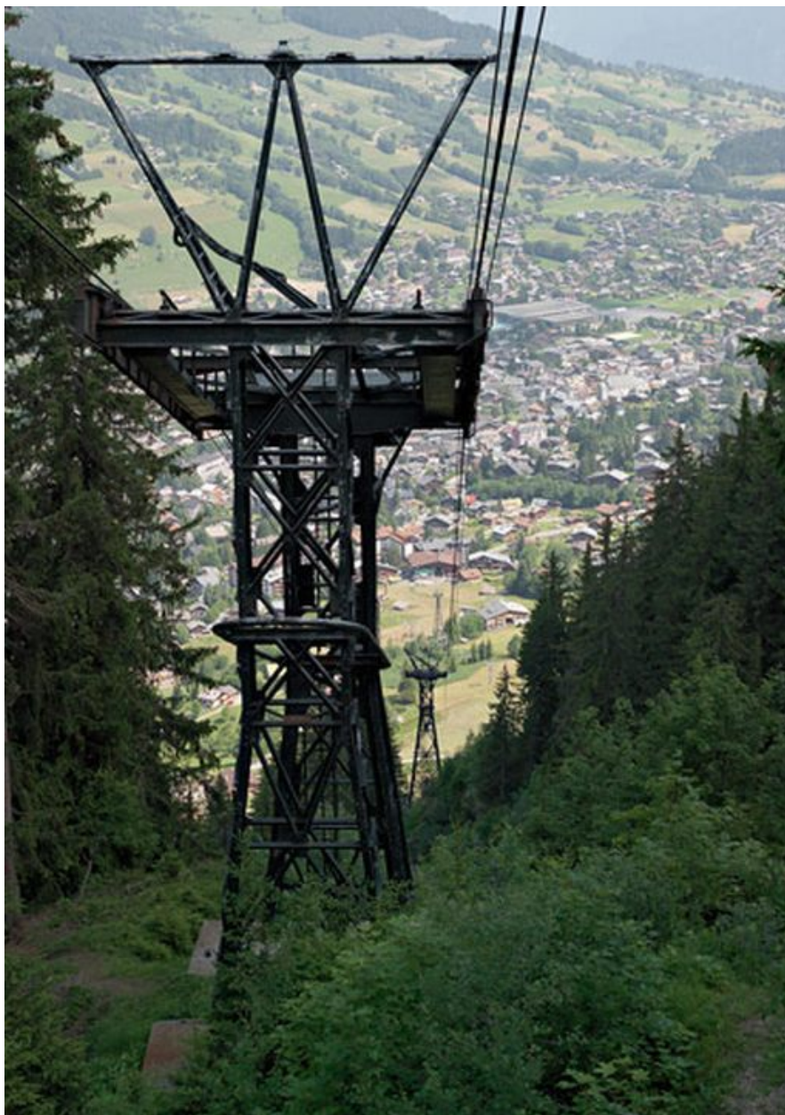
Vue des pylones supportant les câbles depuis l'amont
