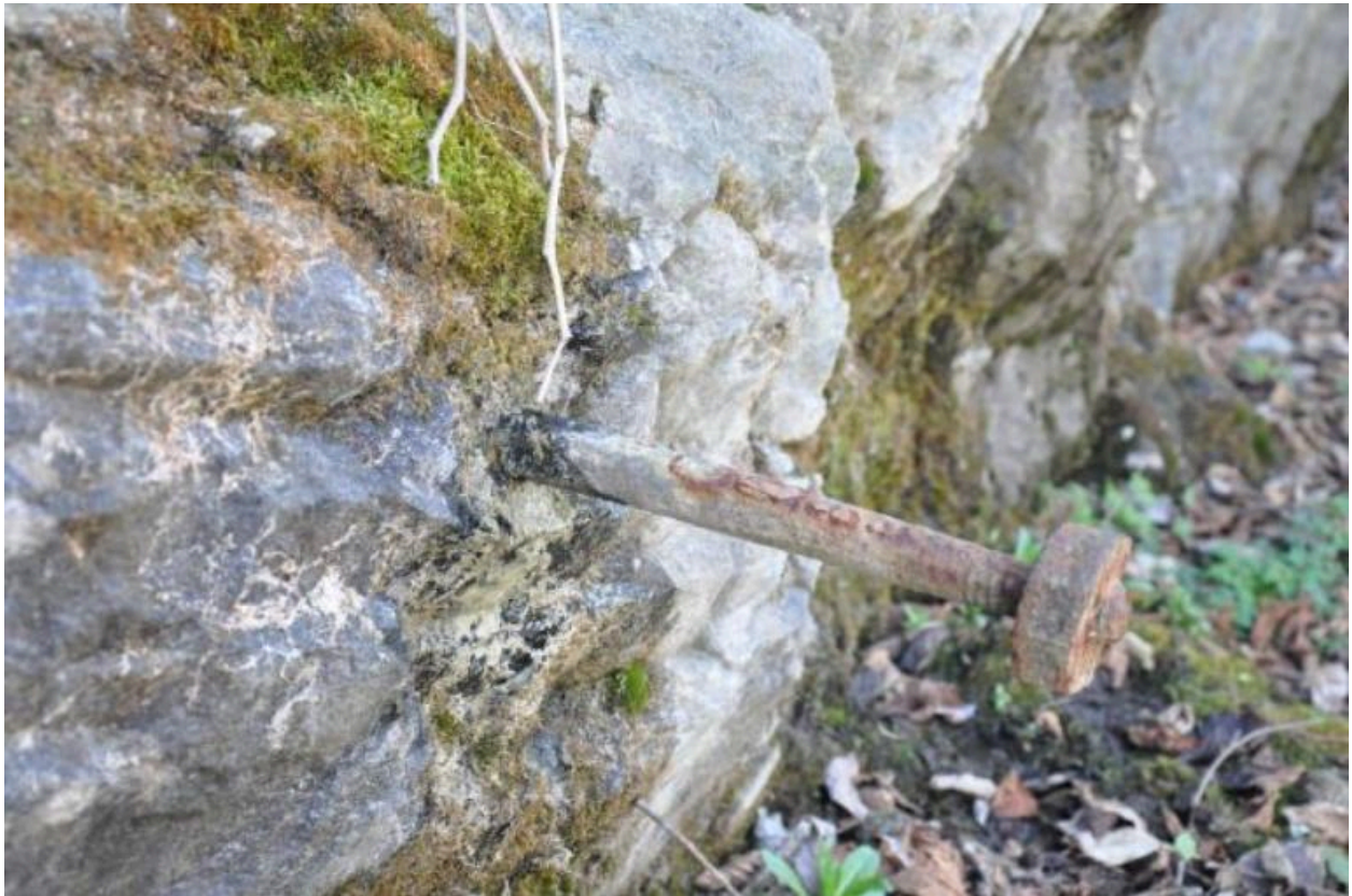
Détail d'une tige de métal qui soutenait autrefois le canal de dérivation du martinet.
