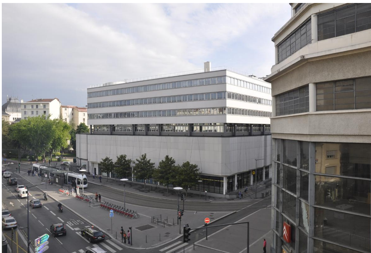
Vue d'ensemble sud-est actuellement
