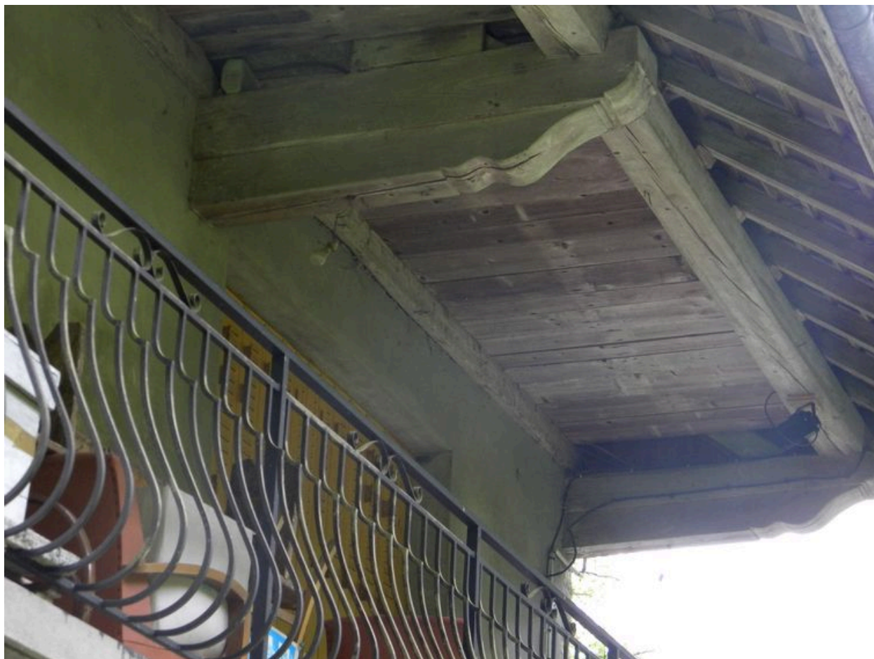
Détail des solives de charpente.
