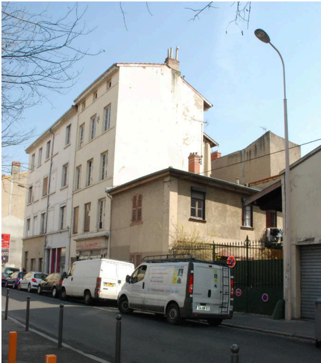
Immeuble et maison démolis (vue prise en 2012)
