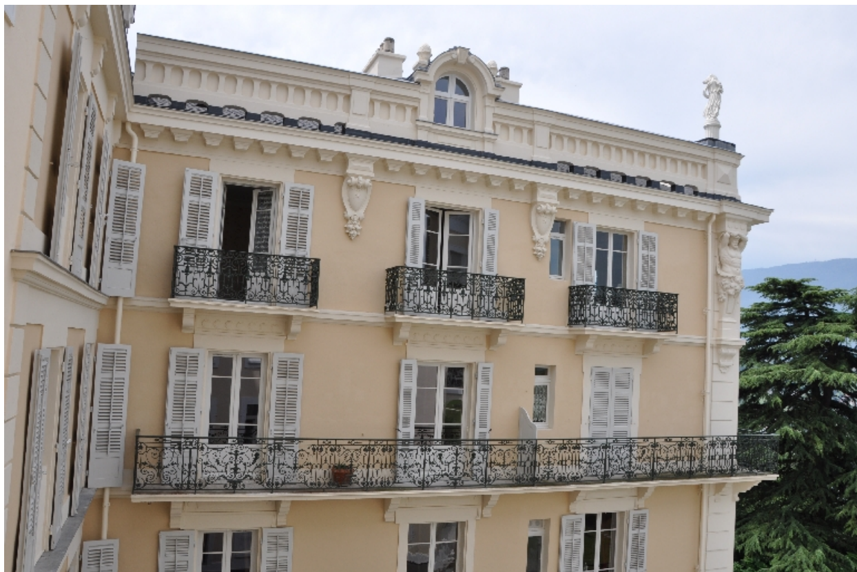
Façade nord, partie supérieure
