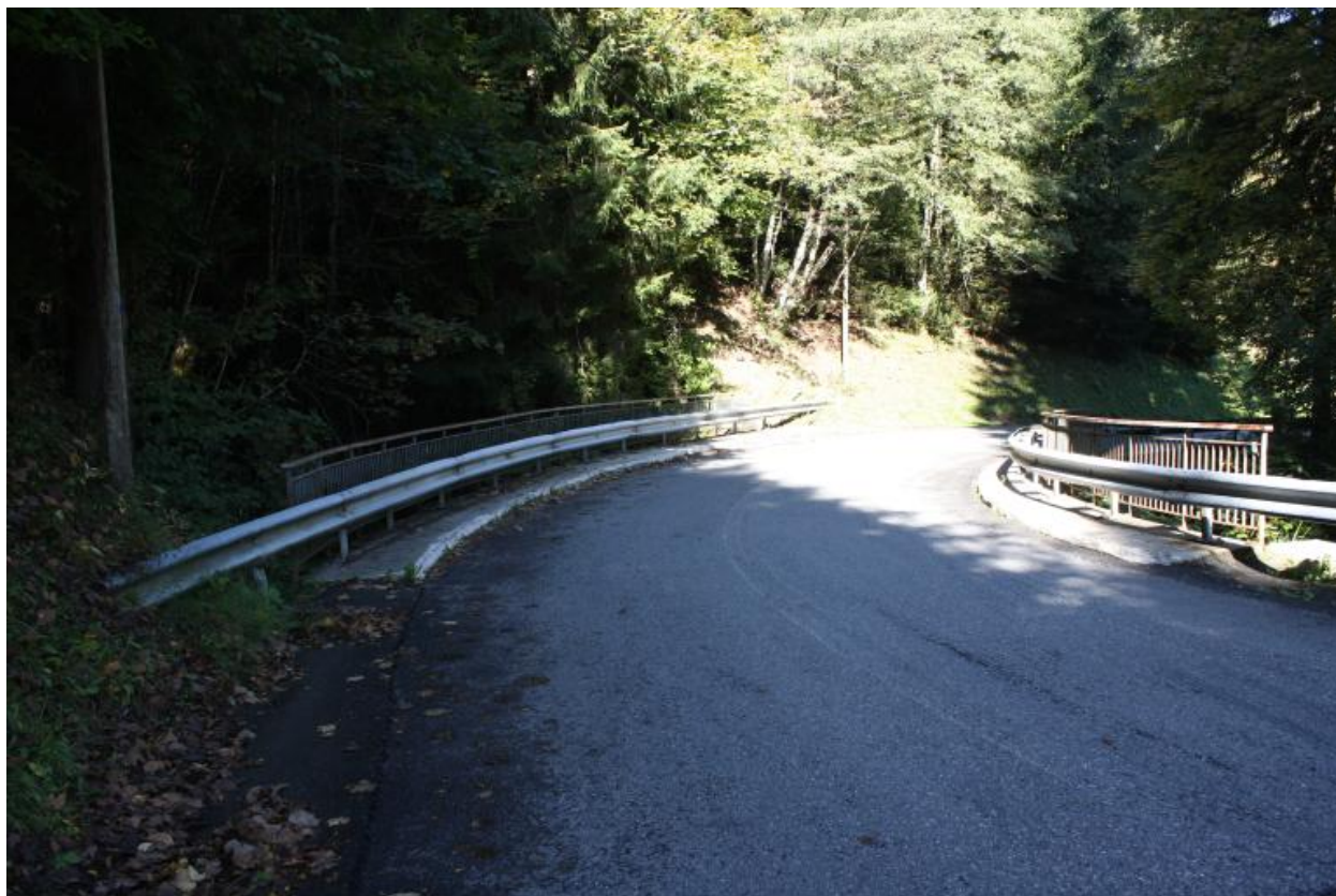
Pont de la Panosse, vue chaussée et garde corps
