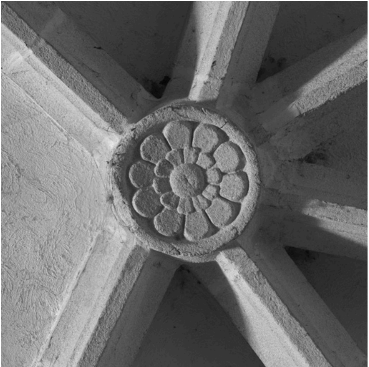
Clef de voûte, rosace, de la voûte du choeur de l'église paroissiale Saint-Jean.
