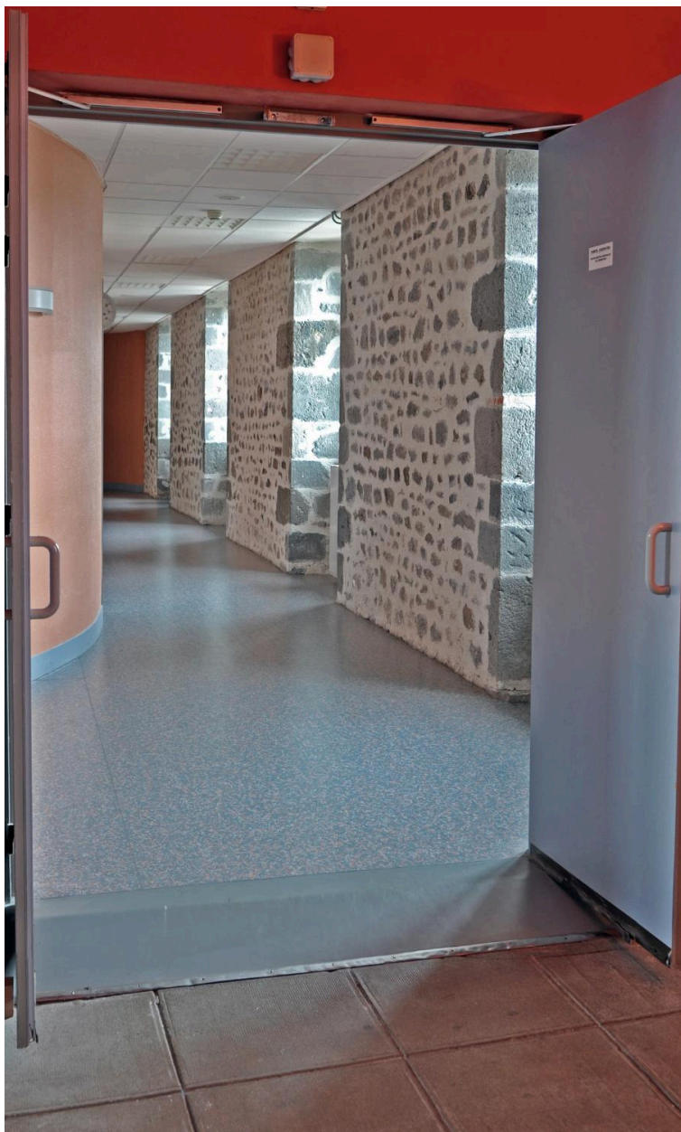
Bâtiment C : couloir du 1er étage, partie est.
