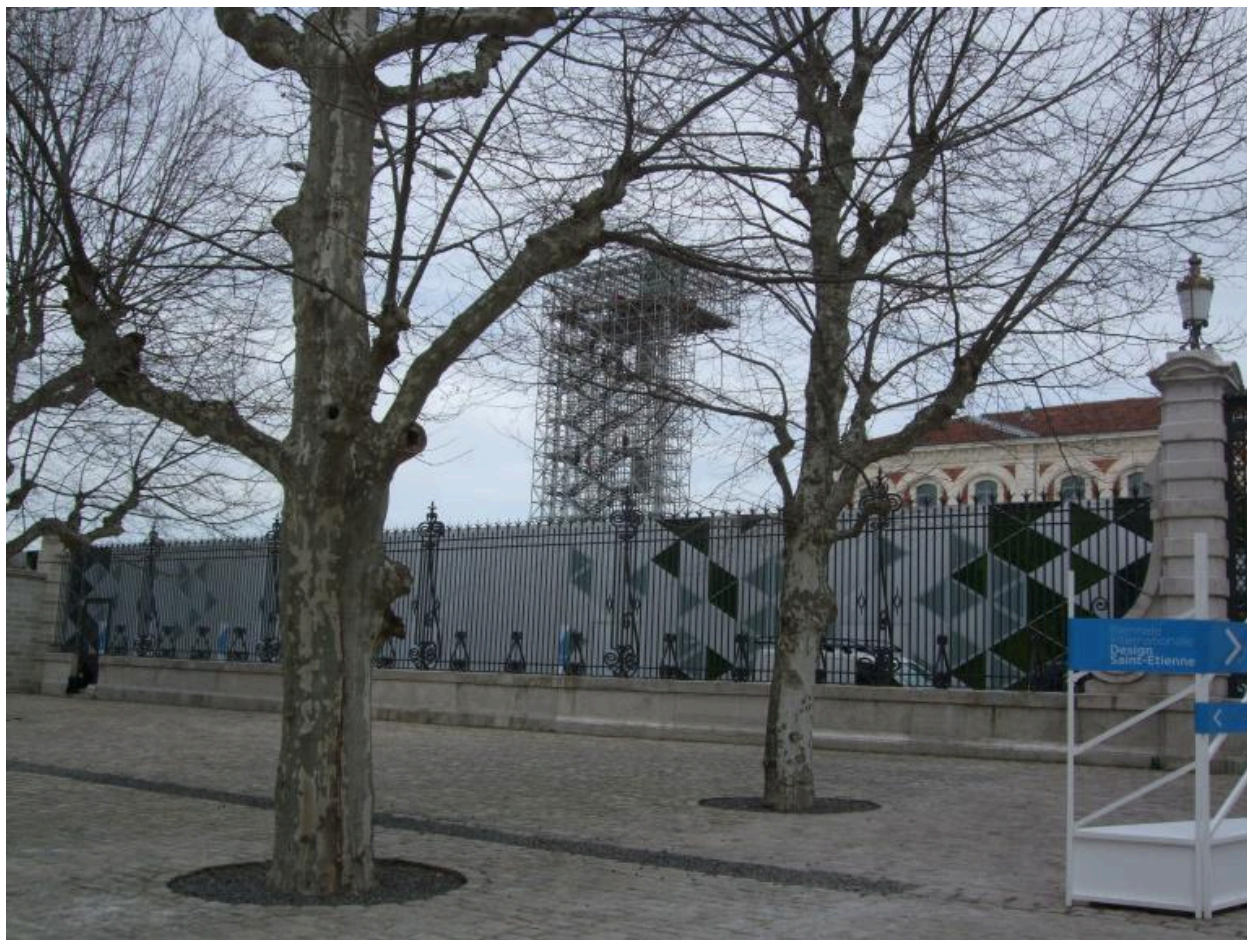
Vue de la tour observatoire métallique.
