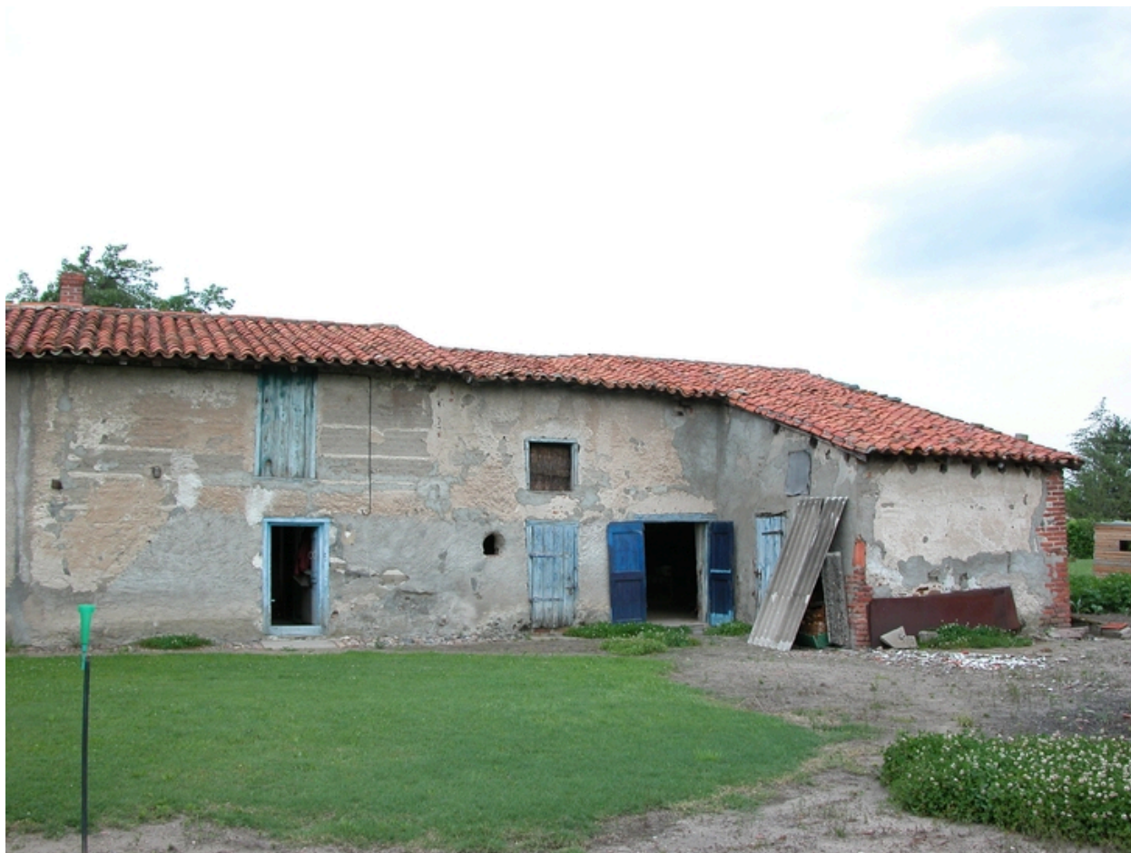
Vue d'ensemble (logis, partie agricole)
