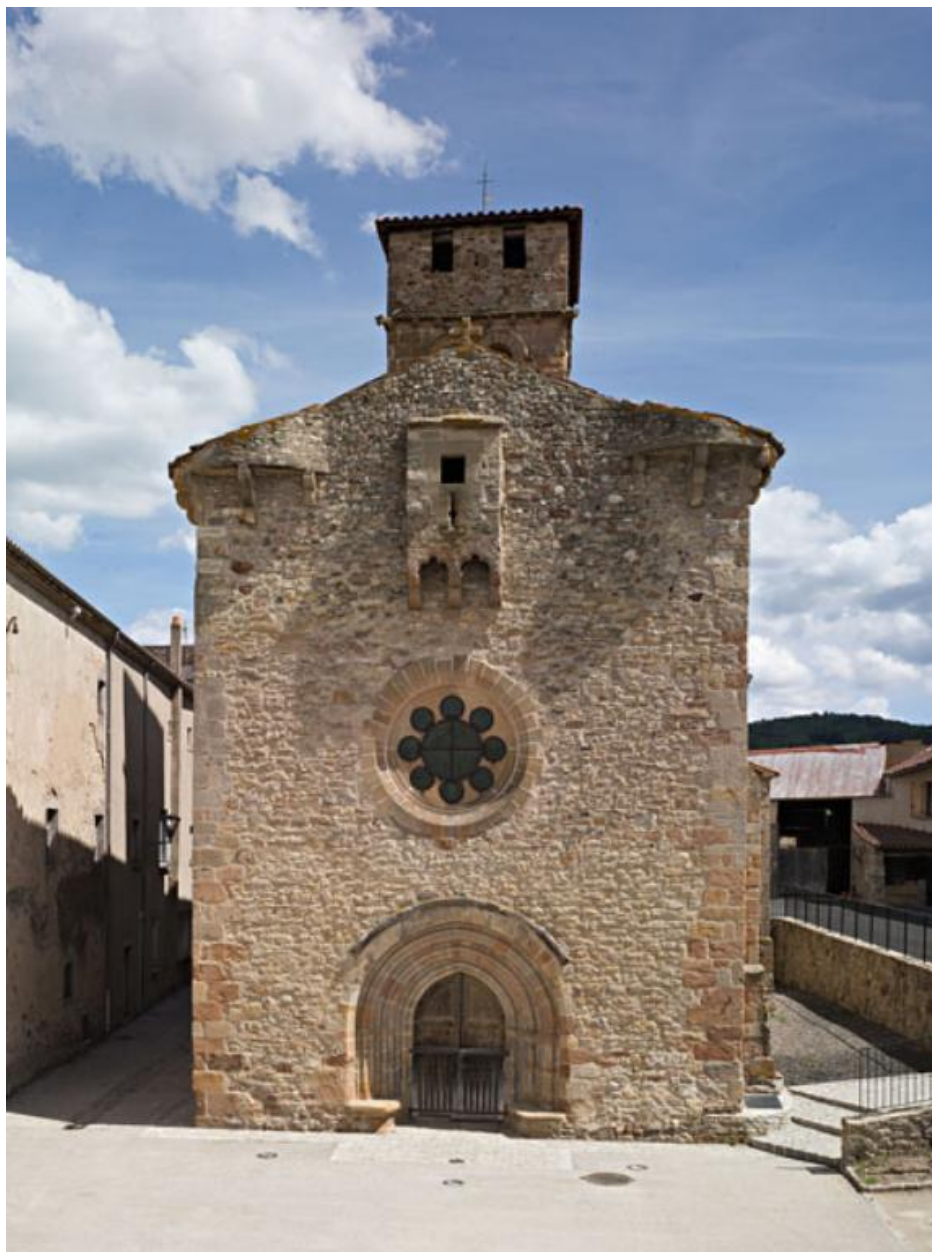
Vue générale de la façade occidentale.
