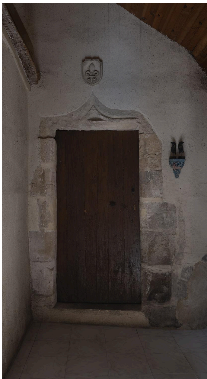
Vue de la porte d'accès à la tour d'escalier
