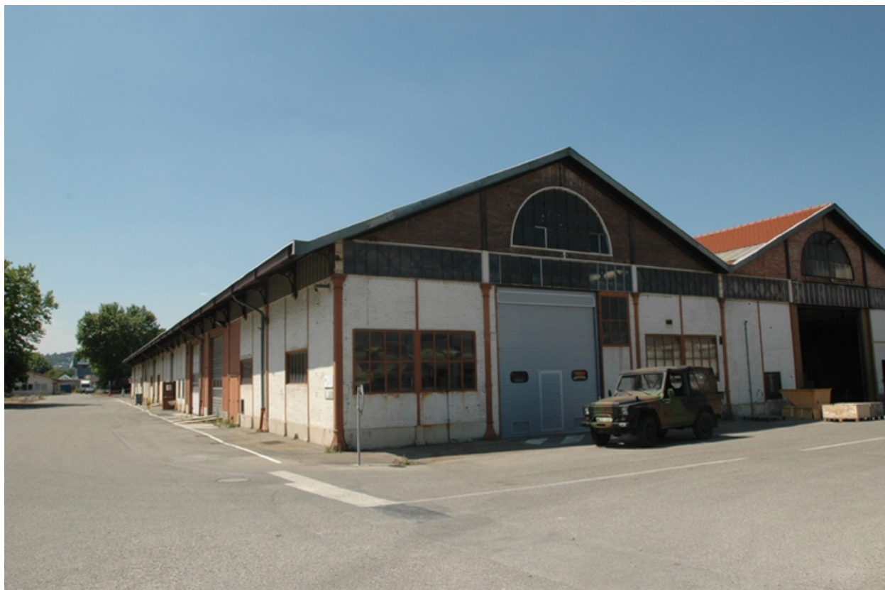
Vue est de l'ensemble 43
