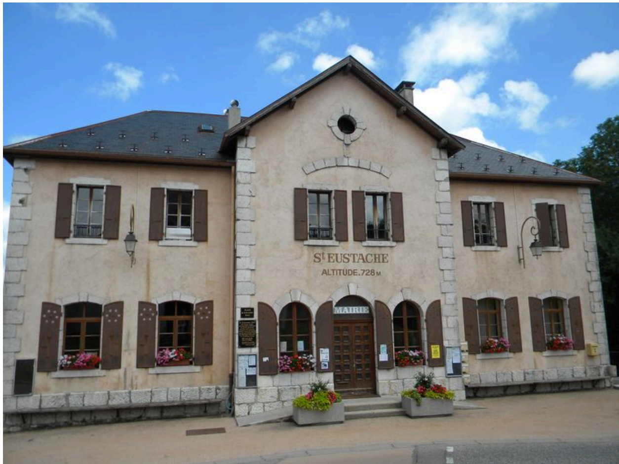
Vue de la façade principale au sud.
