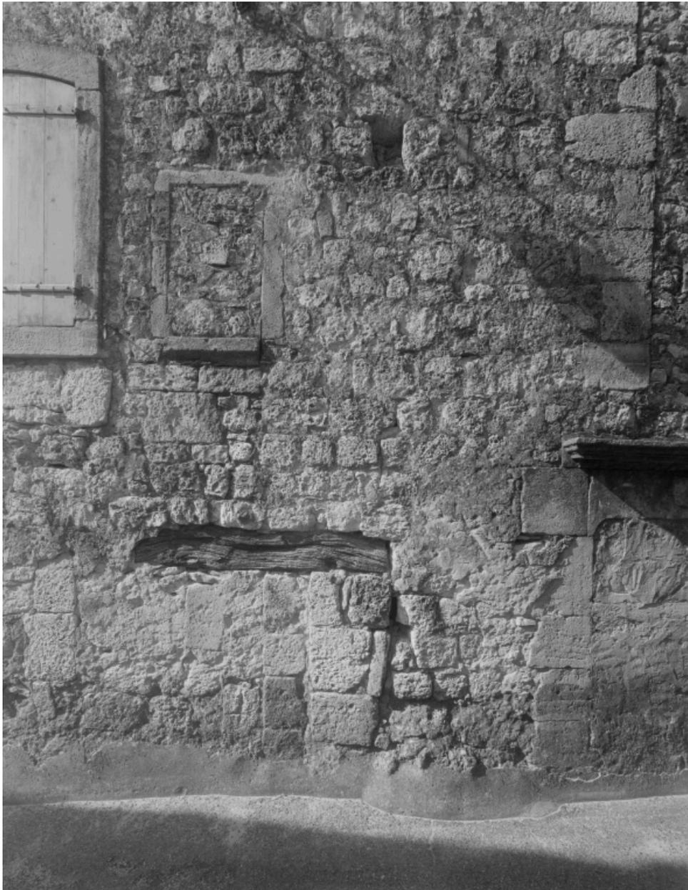
Détail de la façade, partie gauche, montrant plusieurs remaniements : reprise de construction et baies murées.
