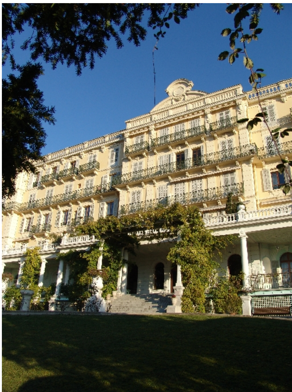
Façade ouest, partie centrale
