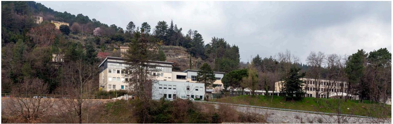
Vue générale depuis l'est
