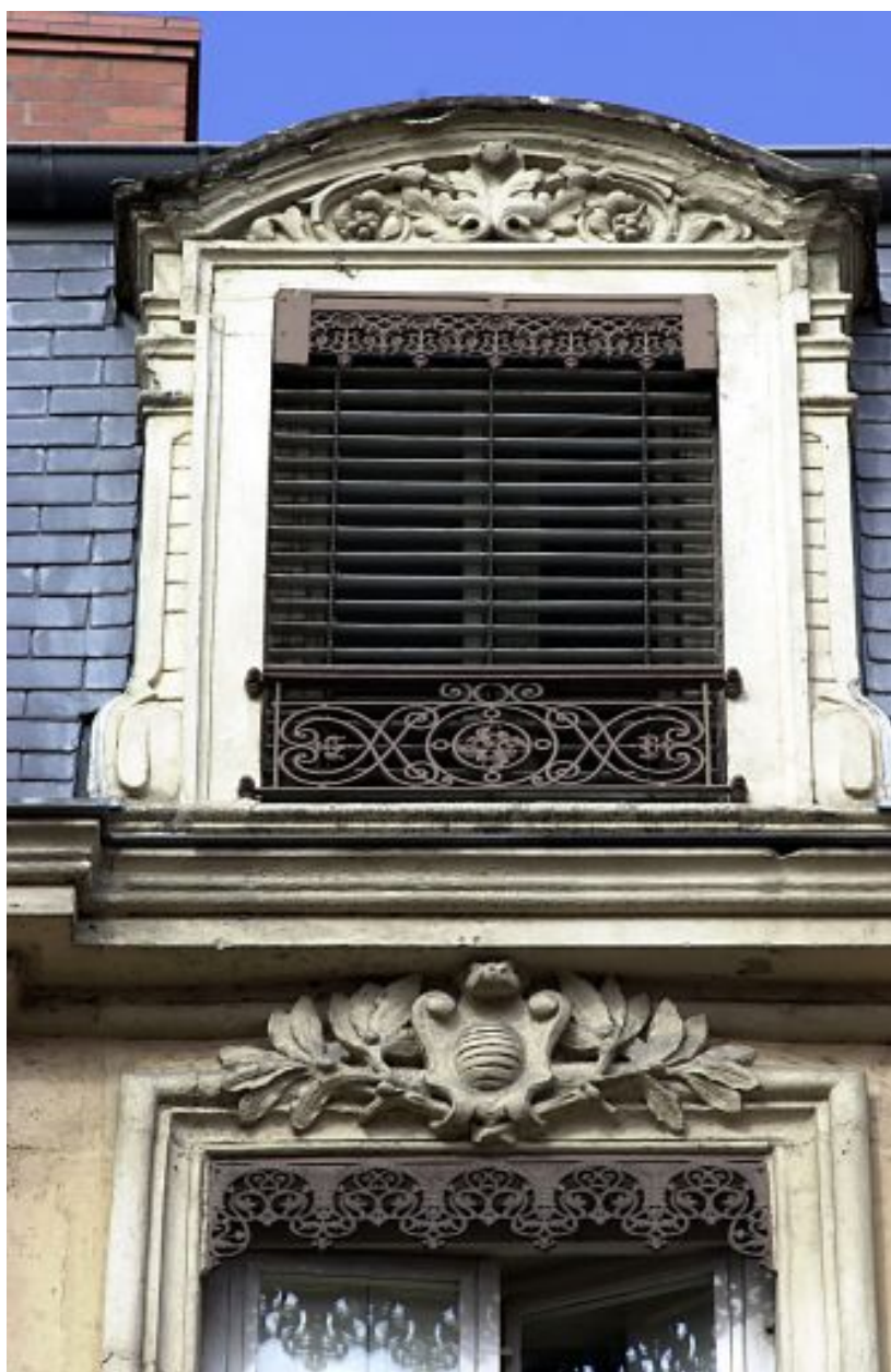
Façade principale, 5e lucarne depuis la gauche
