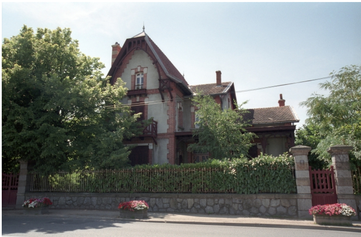
Boën, îlot 13, RN 89, 23. Vue générale de la façade sur rue.
