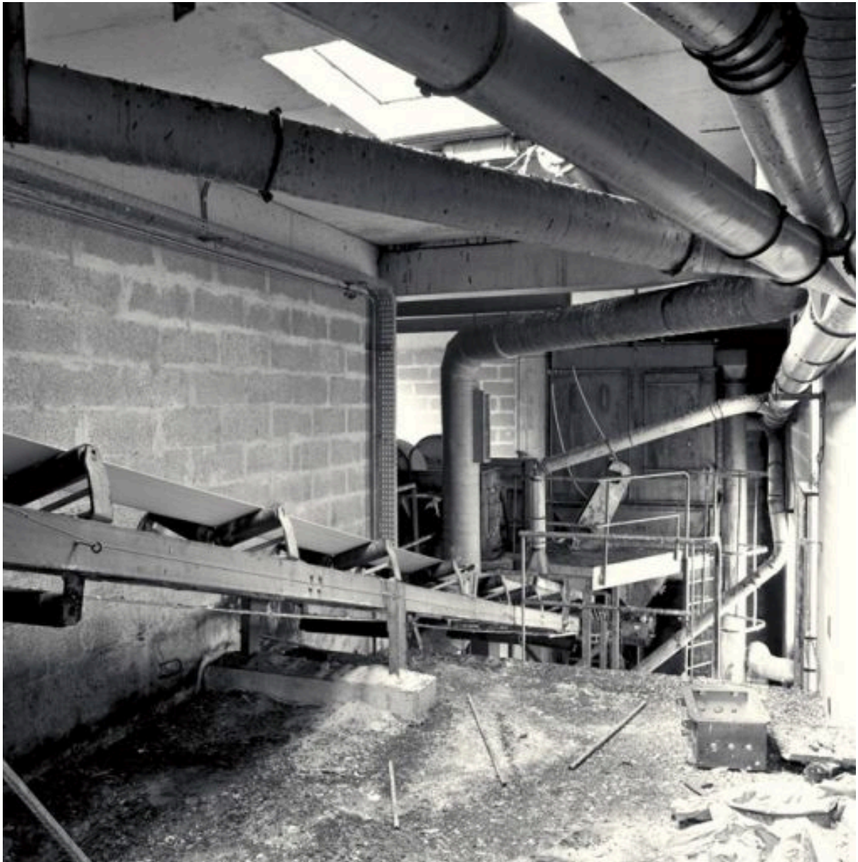
La galerie centrale entre les silos et la cage des élévateurs : vue du transporteur à bandes depuis les silos
