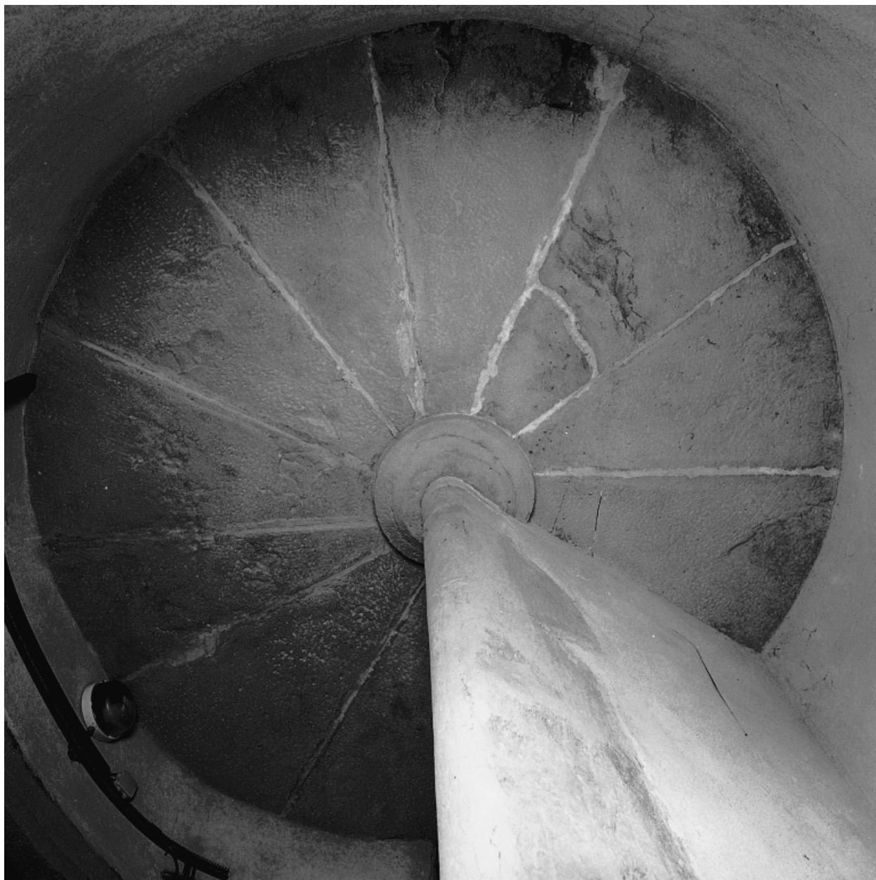
Couvrement de l'escalier.
