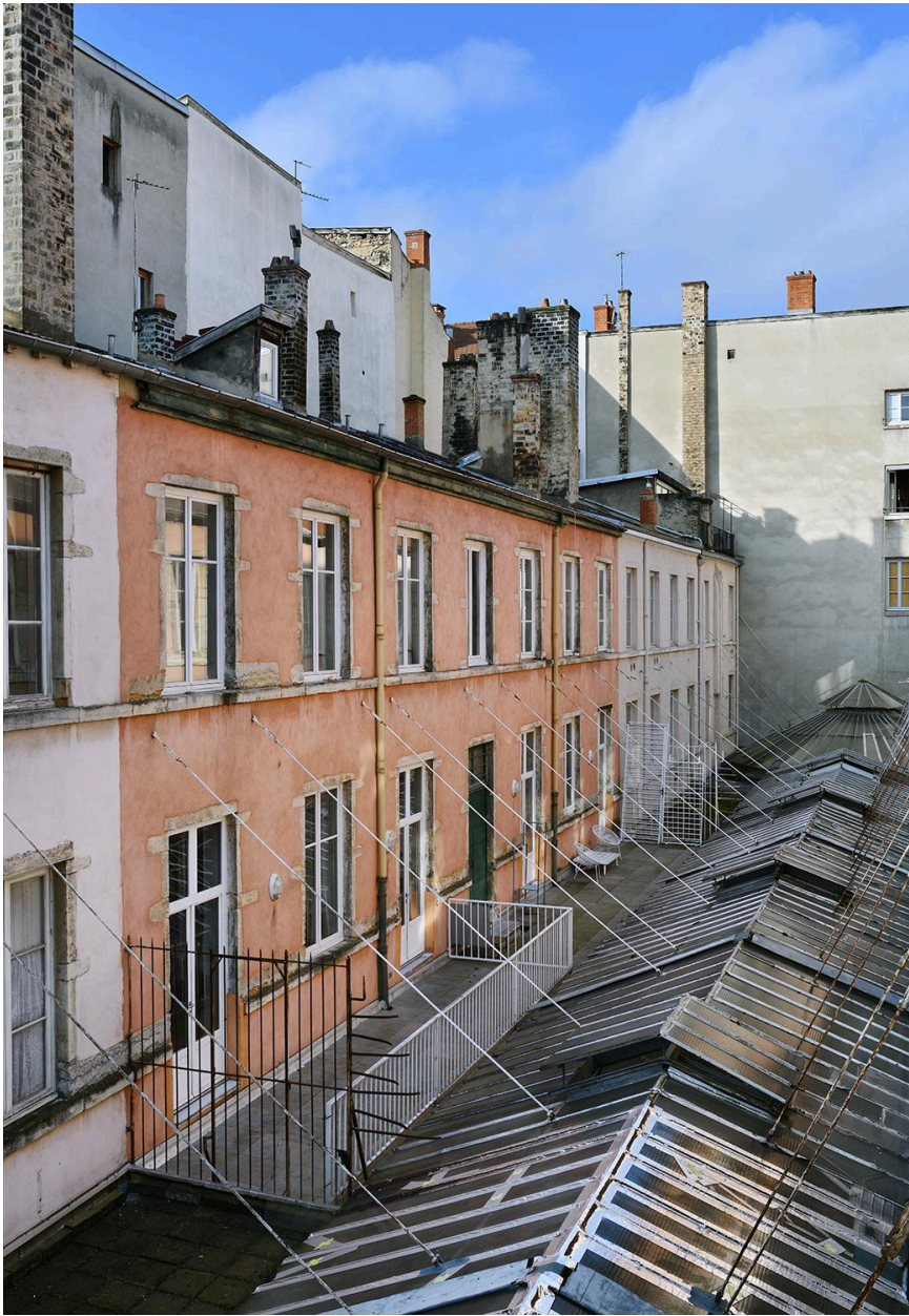
Vue extérieure partielle des immeubles, 2026
