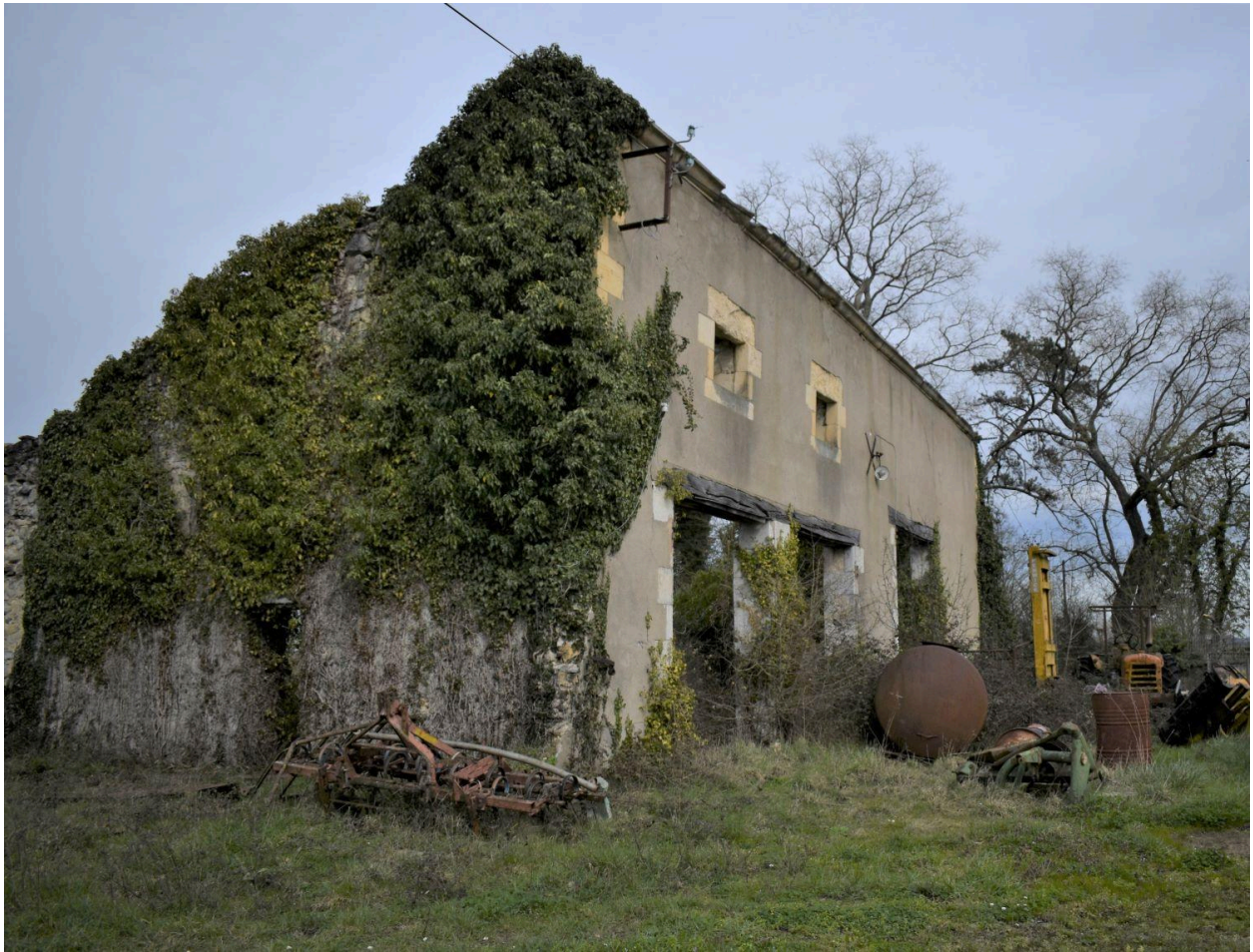
Vue générale de la grange ou étable ruinée.
