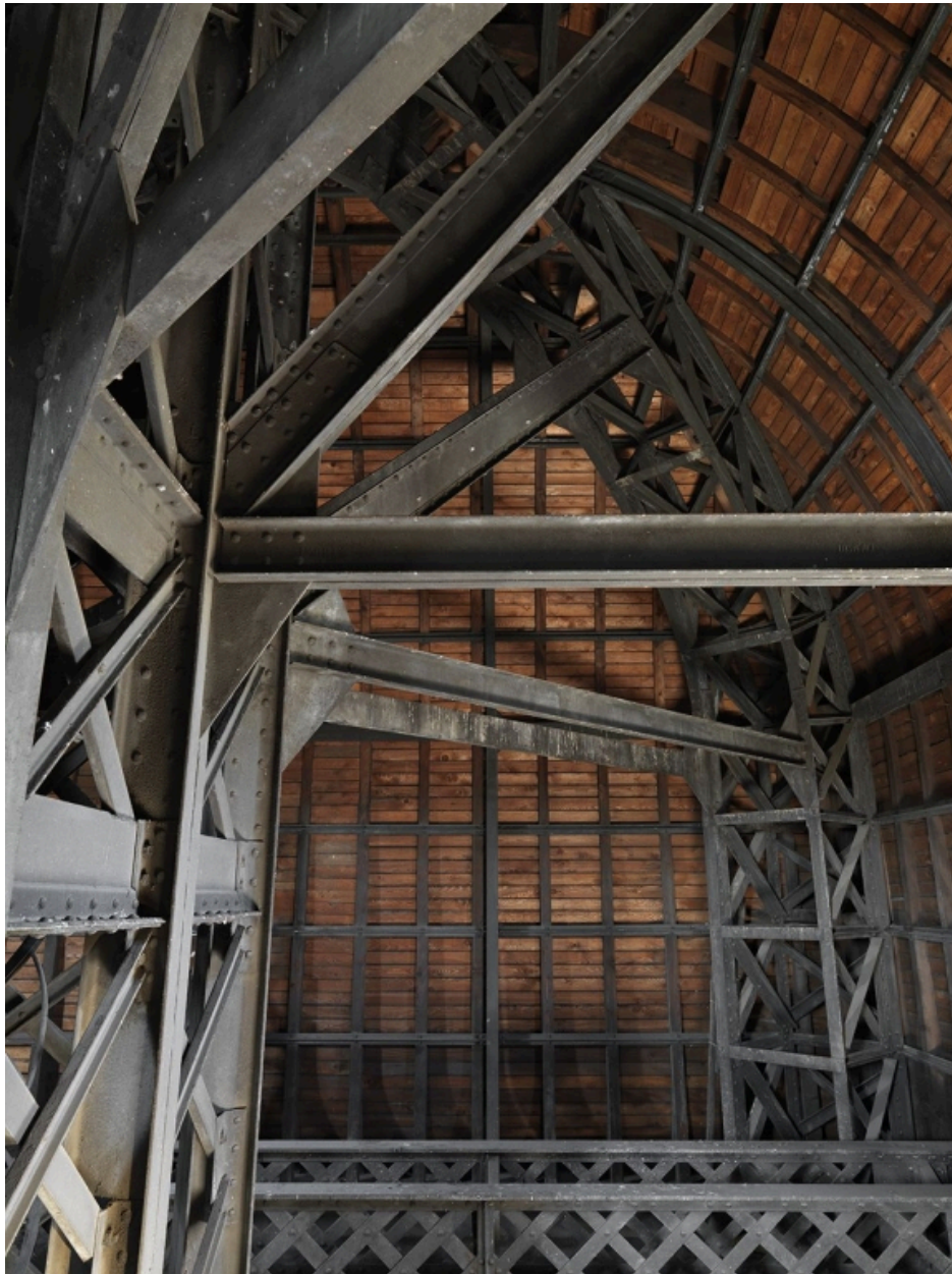
Le dôme Pascalon. 3e étage. La charpente métallique
